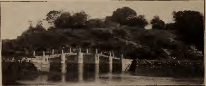
A CANTON BRIDGE.
